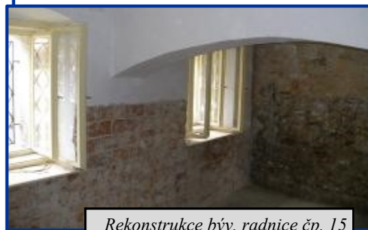
Rekonstrukce býv. radnice čp. 15
